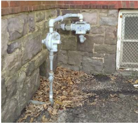
Fig. P-11- Gas Meter
