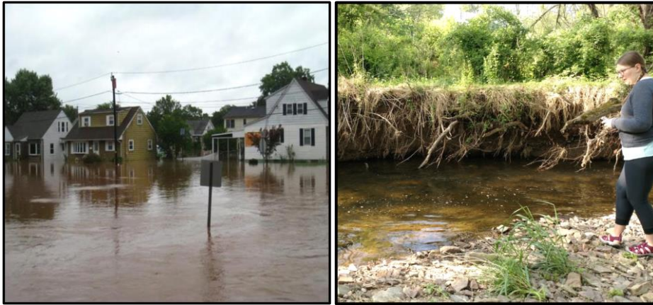
Beden Brook erosion
